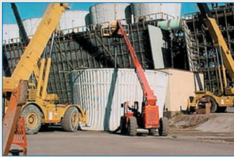
Installing fan cylinders
