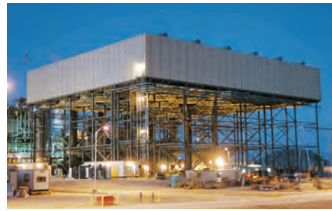
Апекс , США — Конденсатор с воздушным охлаждением для парогазовой установки мощностью 500 МВт.
