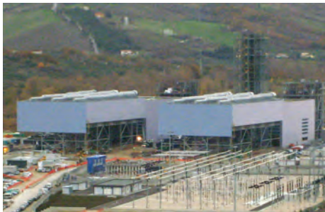
Gissi , Италия — Конденсатор с воздушным охлаждением для парогазовых установок мощностью 2x400 МВт.
