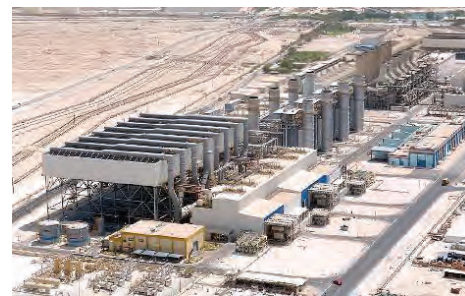
Alba , Бахрейн — Конденсатор с воздушным охлаждением для парогазовой установки мощностью 800 МВт. Проект «под ключ».
