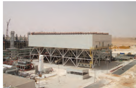
Hassi R'Mell , Алжир — Конденсатор с воздушным охлаждением для парогазовой установки мощностью 150 МВт – Солнечная электростанция.
