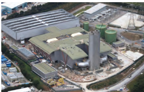
Langage , Великобритания — Конденсатор с воздушным охлаждением для парогазовой установки мощностью 850 МВт.
