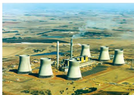
Самая большая в мире система сухого охлаждения с естественной тягой. Электростанция «Кендал» 6 x 690 MW, ЮАР
