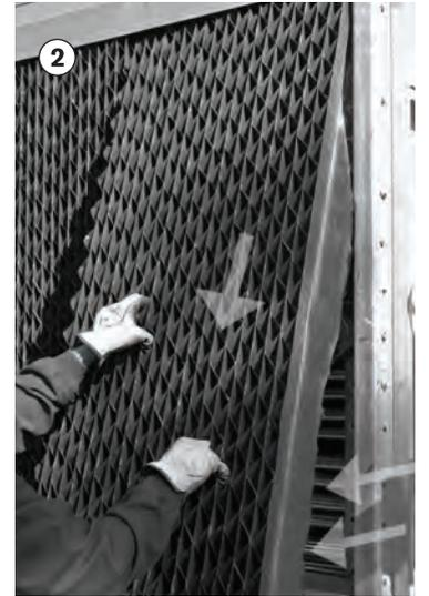
要拆卸百叶，请将双手放在百叶区并向上推，这将使一个组合件停止，同时另一个组合件启动。向上推动一个百叶部分，直到它撞到金属保留钢管顶部为止 (1)。将百叶底部从冷却塔中拉出，并卸下百叶 (2)。对其他包重复此步骤，以进行必要的操作。
