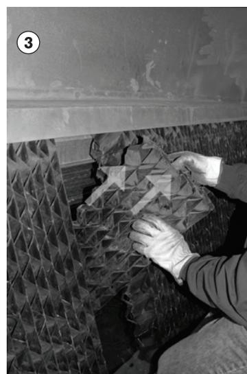
要拆卸除水器，请将双手放在除水器区并向上推，这将使一个组合件停止，同时另一个组合件启动。向上推动一个部分，直到它撞到金属保留钢管顶部为止(1)。将包的底部向下推入冷却塔(2)。将包放置一旁，卸下除水器(3)。对其他包重复此步骤，以进行必要的操作。正确替换除水器包对操作很重要。不正确的安装会导致漂滴损失过快和风扇效率低下！为确保包重新安装时方向正确，建议将一个包保留在冷却塔内的原始位置，以提醒包的方向。请按照拆卸包的顺序将包放置到闭式冷却塔内。包应该相互紧密嵌套，整体呈现出一个无缝的水平面。
