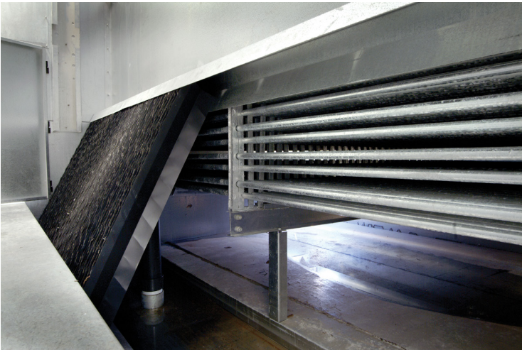
MH 闭式冷却塔下部的盘管便于清洗和检修。
