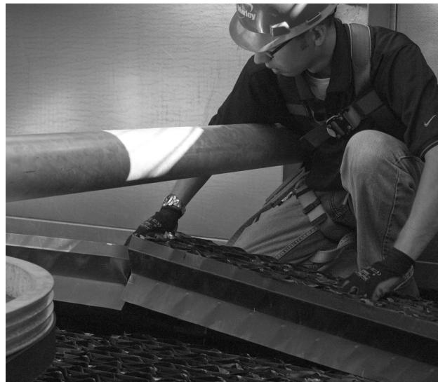
要拆卸除水器，请站在检修板内，将双手放在除水器上并向上提，以此判断两个段的连接位置。提起除水器的连接处，一次拆除两个除水器包
