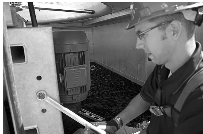
应将新皮带(工作时间不足 8 小时) 的松紧度调至最大值。在此时间之后，使用的松紧度应不小于最小值。如果皮带跨距的测量以英寸为单位，那么力值请使用磅。如果皮带跨距的测量以厘米为单位，那么力值请使用千克。如果松紧度调节工具提供了特定的松紧度调节说明，那么应该使用这些说明。
