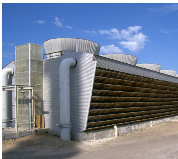
**TORRE DI RAFFREDDAMENTO DI TIPO FIELD ERECTED A FLUSSO
