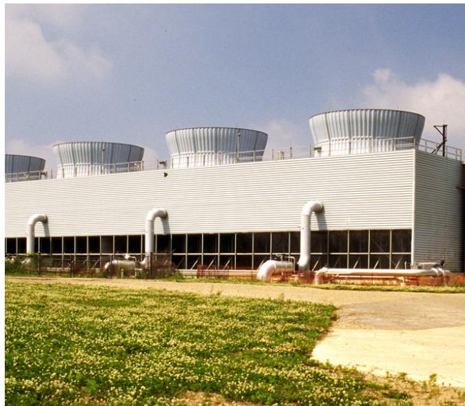
**TORRE DI RAFFREDDAMENTO DI TIPO FIELD ERECTED
