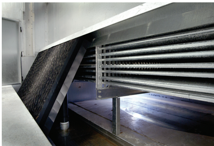
Umieszczenie chłodnicy w dolnej części schładzacza cieczy MH ułatwia dostęp podczas czyszczenia i kontroli urządzenia.
