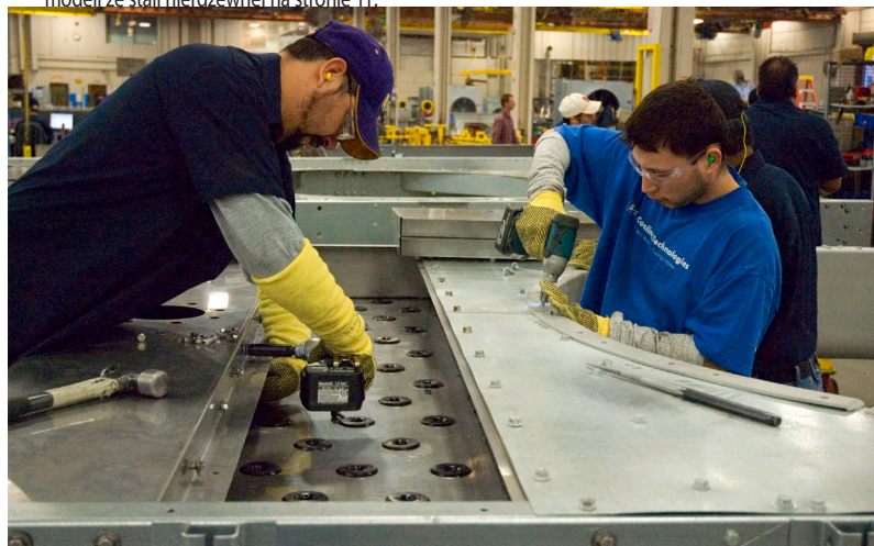
Montaż w zakładzie
