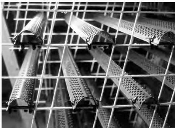
РИСУНОК 2А Установленный брызгальный ороситель
