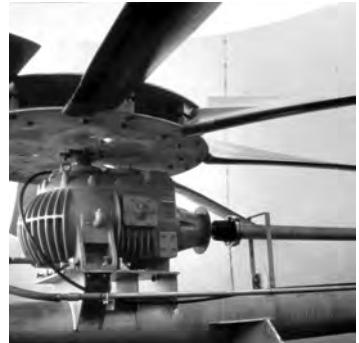
■ Скорость лопастей многих крупных вентиляторов, используемых в градирнях, достигает 3,962 м/с. Когда на кромку лопасти попадают случайные капли воды из сепаратора, то в случае, если лопасти не подготовлены к таким условиям, на передней кромке лопасти может образоваться эрозия. Со временем это может привести к неисправности вентилятора.
