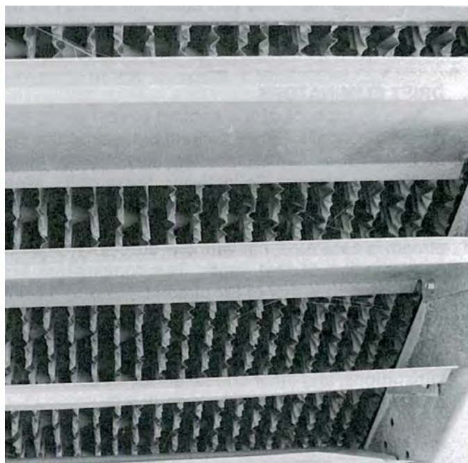
РИСУНОК 14 Термоформованный ороситель с независимыми жалюзи плоского типа
