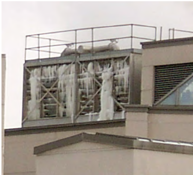
РИСУНОК 15 Пример эксплуатации поперечно-точной градирни с независимыми жалюзи плоского типа
