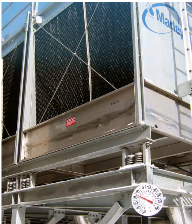
РИСУНОК 16 Пример эксплуатации поперечно-точной градирни со встроенными жалюзи
