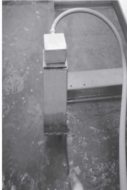
Sonda de electrodo instalada en una torre de enfriamiento de flujo cruzado NC ® de Marley
